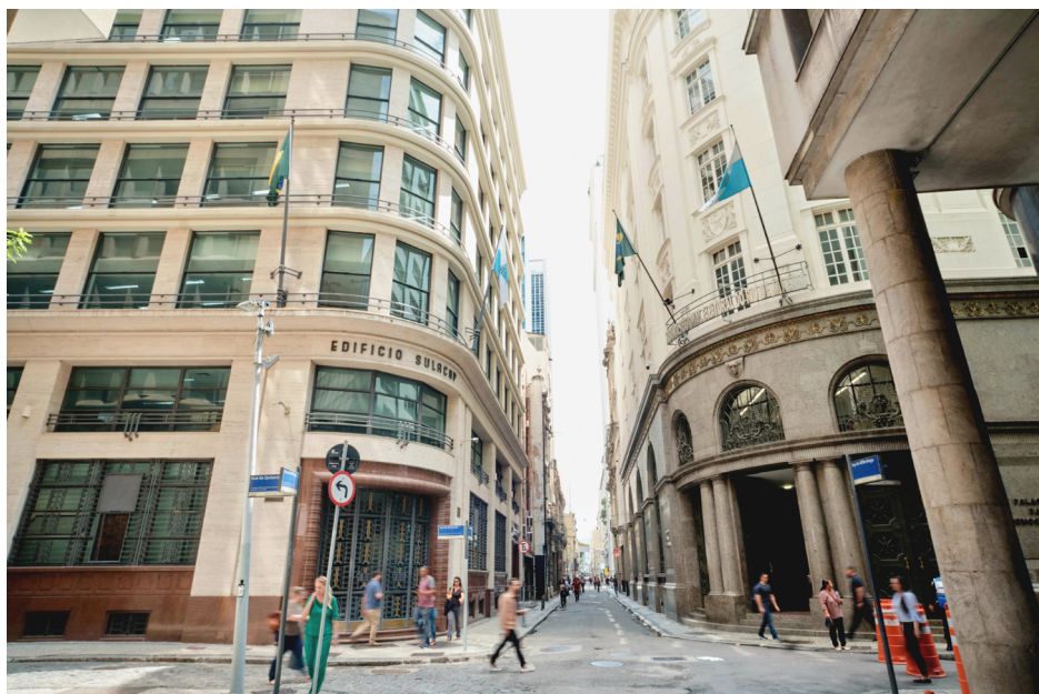
Figura 4.1.4.1: Foto das fachadas do Ed. Des. Antônio Jayme Boente, na esquerda, e do Palácio da Democracia, na direita, prédios que compõem a sede do TRE-RJ
