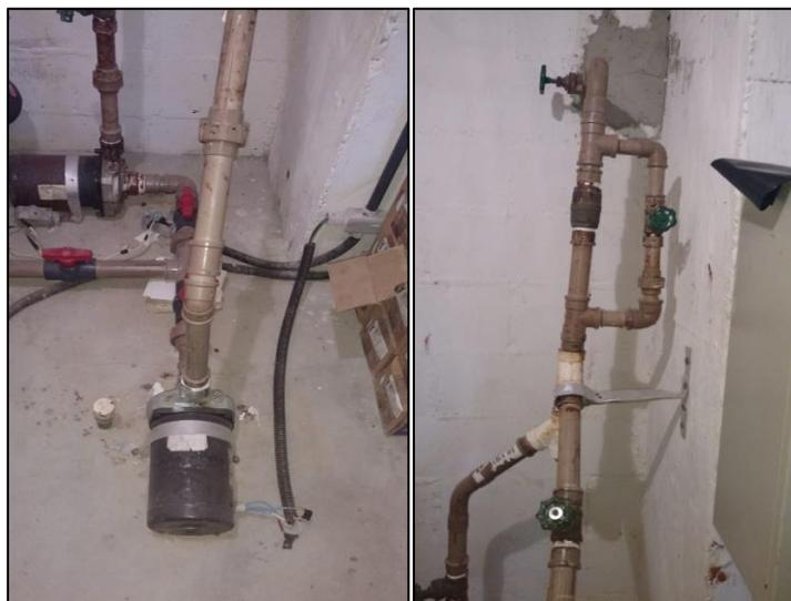
Figura 11.10 - Conjunto de motores e tubulações do sistema de recalque
